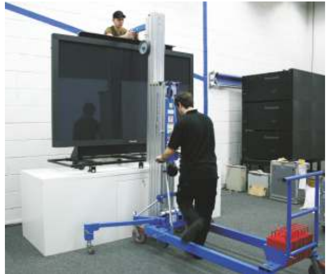
Schwere und große Lasten sicher heben und positionieren mit dem Wienold SLK
